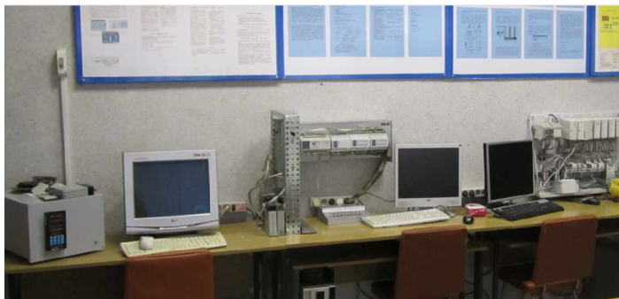
Рис. 1. Общий вид лабораторных стенов на базе микропроцессорных контроллеров КР-300. ТЕКОНИК
